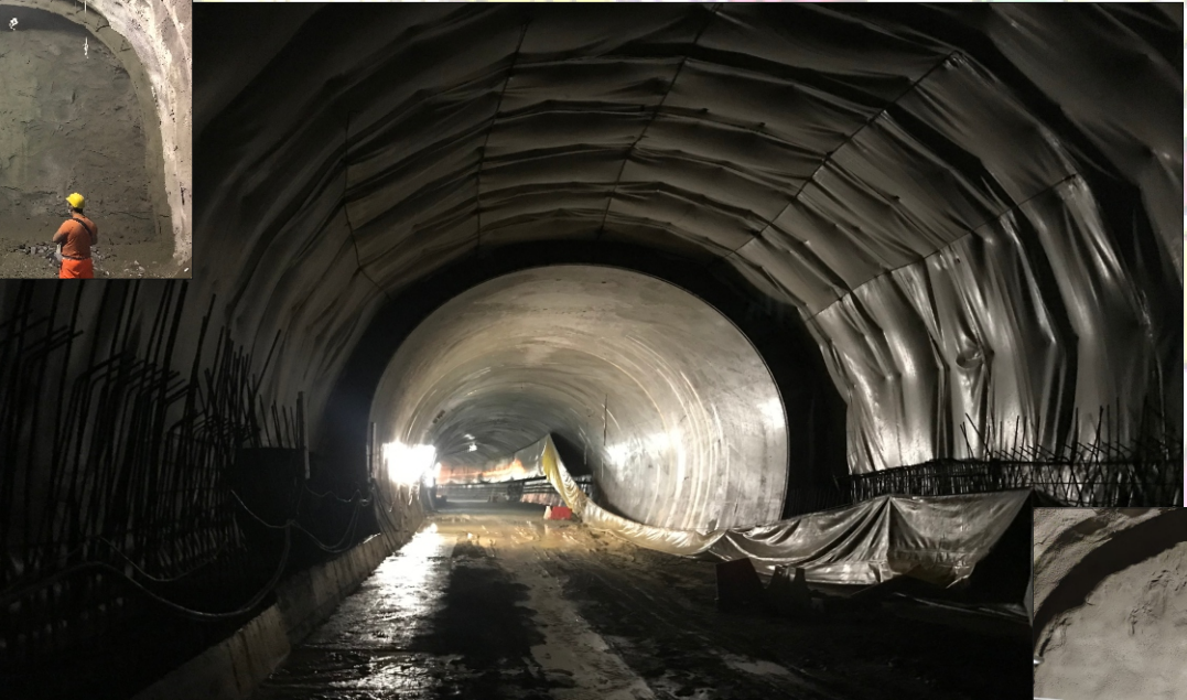
Nuovo tunnel del Colle di Tenda (Italia - Francia) a doppio fornice, Limone Piemonte (CN) - ANAS S.p.A.
